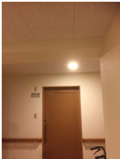
(5)廊下 2F (212号室前)
