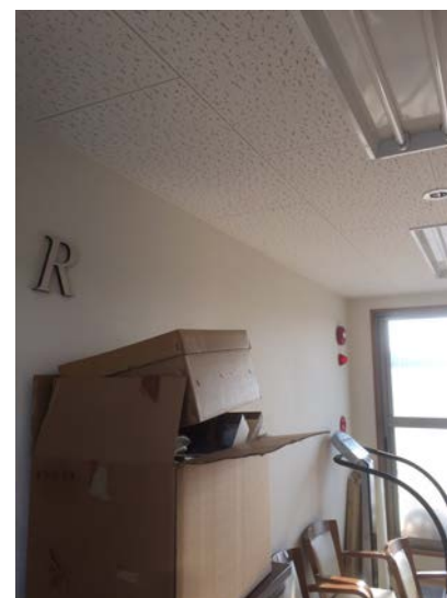
(8)備品保管倉庫(屋上横)
