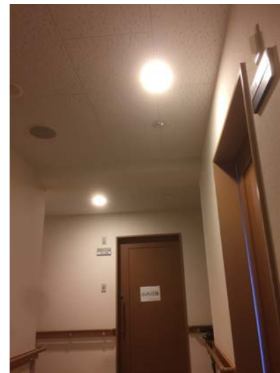
(6)廊下 3F (312号室前)
