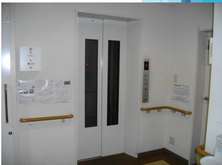
エレベーター
